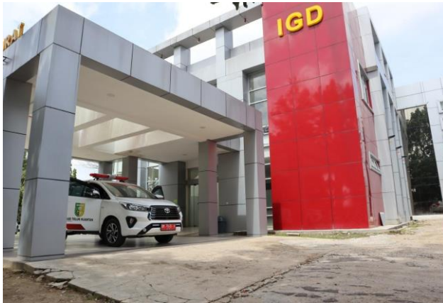
Gambar 6 Bangunan IGD RSUD Telukkuantan
